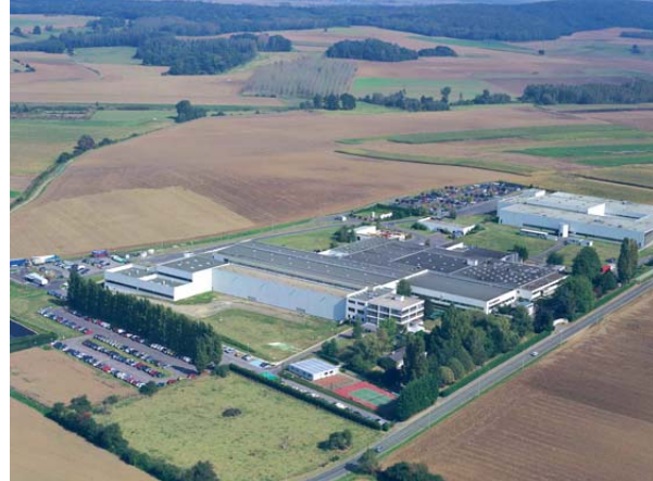
L'usine Yves-Saint-Laurent à Lassigny
